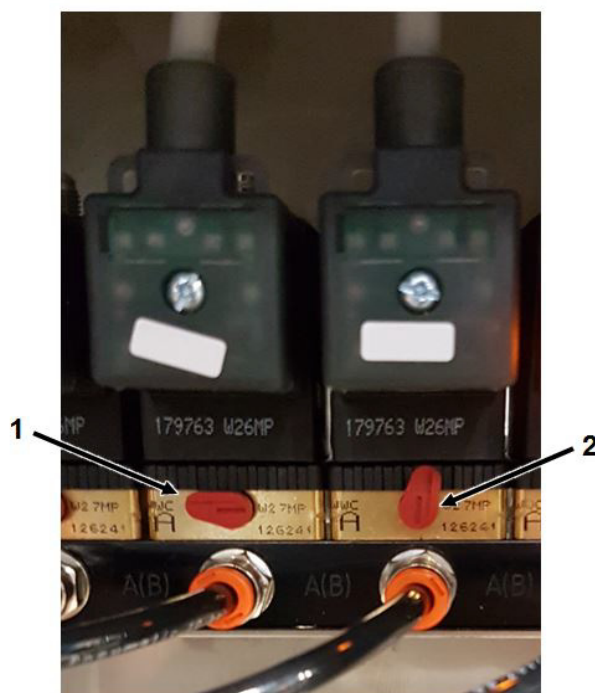
Fig. 0-121 Tvangsstyrning af luftaktuatorer for ventiler
