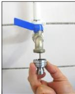
1. Vissez le raccord 1/2" (article n° 5361GA3) sur le robinet d'eau.
